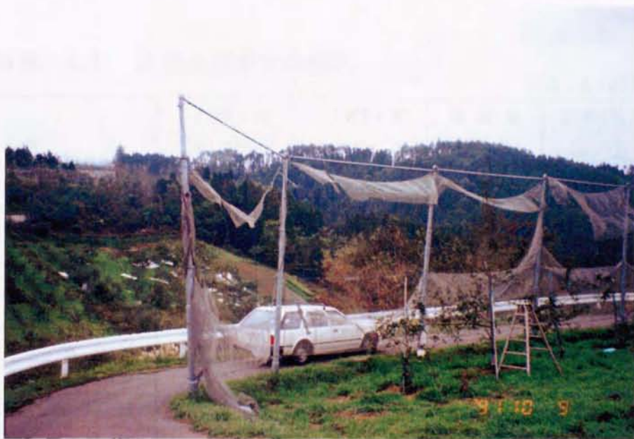
台風19号以前に破損していた防風ネット 一度破損するとなかなか直さない (黒石市浅瀬石) 写真-19
