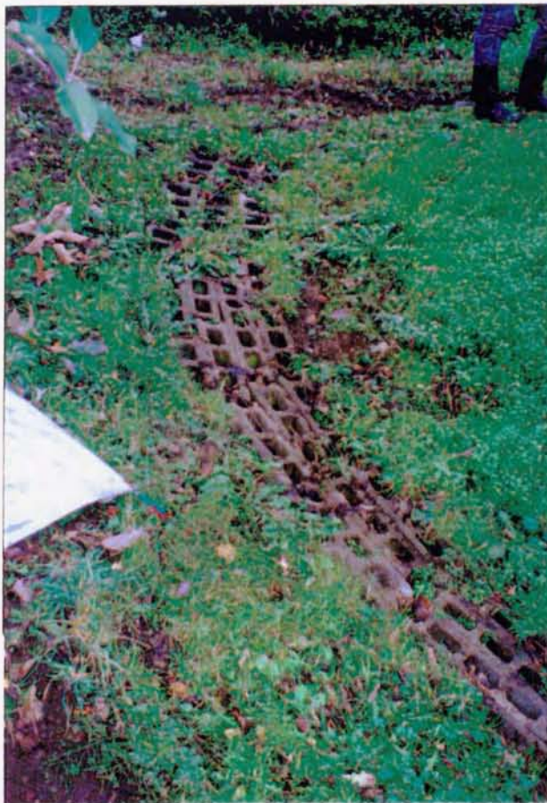
旋回部内側に敷設した建築 ブロック、写真-11とはブ ロックの並べ方が少し違う (平賀町唐竹) 写真-12
