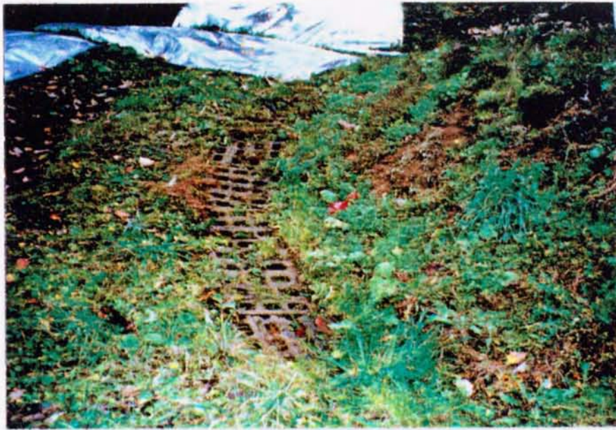
旋回部内側に敷設した建築ブロック (平賀町唐竹) 写真-11
