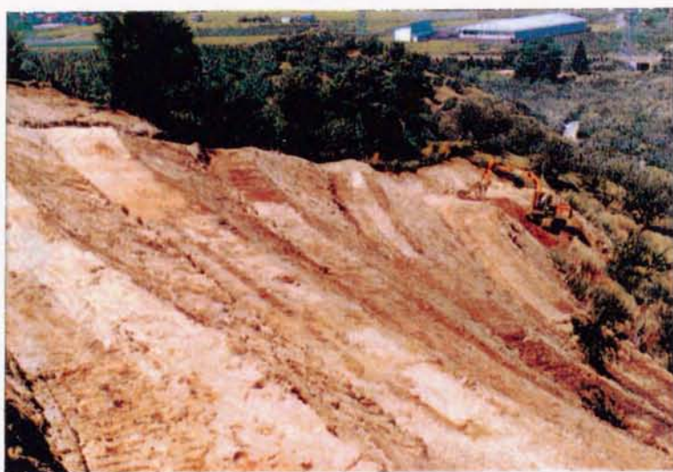
しらす地帯におけるりんご園の造成 造成方式は耕作道型斜面畑である (平賀町新館)
