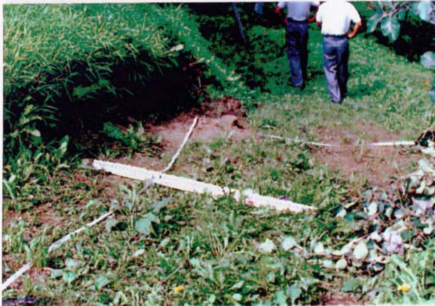
死亡事故のあった現場 左側の法尻に乗り上げ転倒 (平賀町沖館) 写真-10
