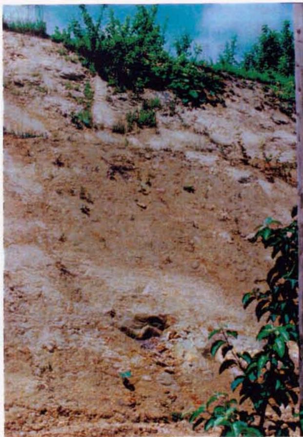
上の写真の切土法面部分 (弘前市石川) 写真-16
