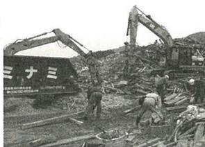
写真2、写真3 / 山田町の震災廃棄物集積場での分別チップ化の作業。被災して仕事を失った人が雇用され、金具や釘などを除去の作業を行っている。
