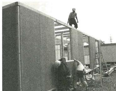
写真5、6/仮設集会施設の施工の様子。プレカット軸組に、「復興ボード」を用いた床・壁・天井パネルを組み込んでいく構法。
