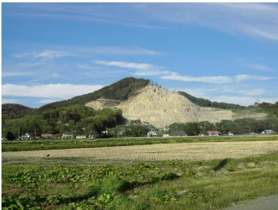
図4.2 残壁の現況写真(平成18年)
